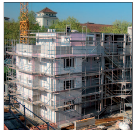
Neubau Osianderhof in Kirchheim (S.17)
