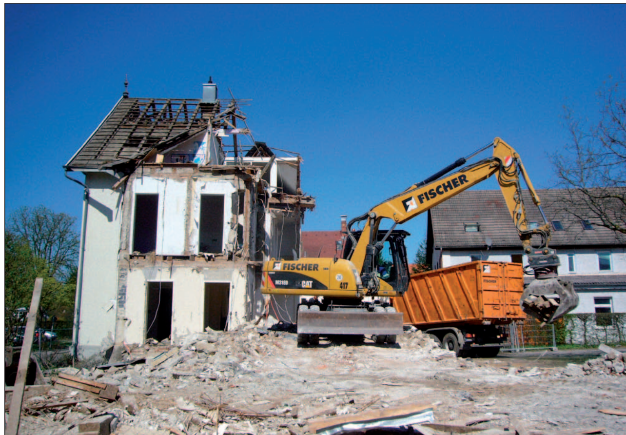
Abbruch der alten Wepamat Gebäude
